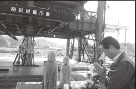
南三陸町防災対策庁舎
